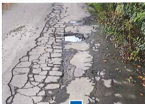
埼玉中学校 北側道路の道路補修
